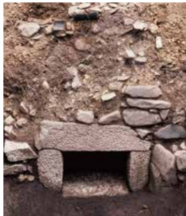
5 上京区馬喰町(北野天満宮境内) 石組み暗渠排水口
