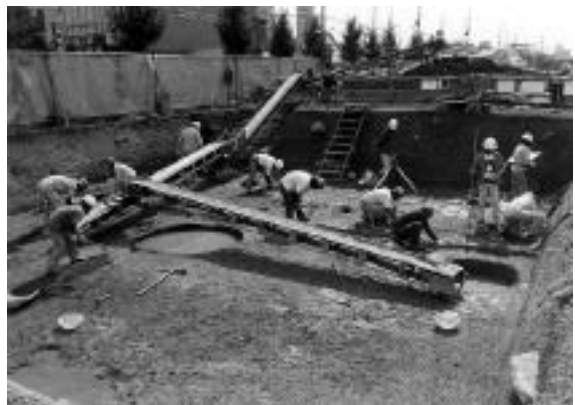
図35 第5工区調査風景
