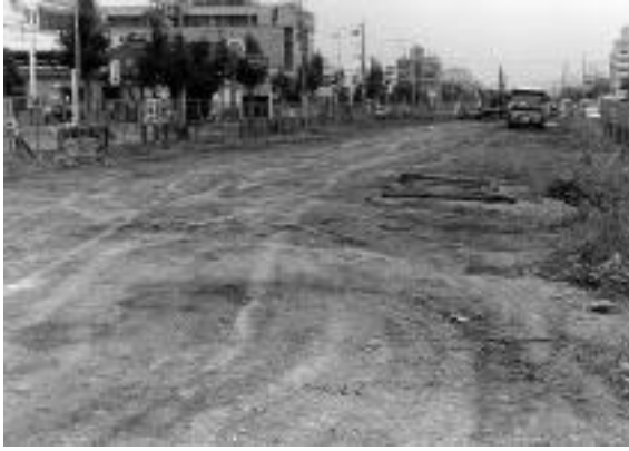
図12 第4工区調査前全景
