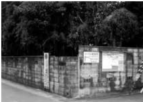
図2 作業開始前の現地の様子(北東から)
