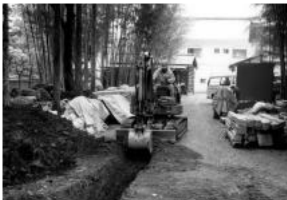
図4 第6区 重機掘削（東から）
