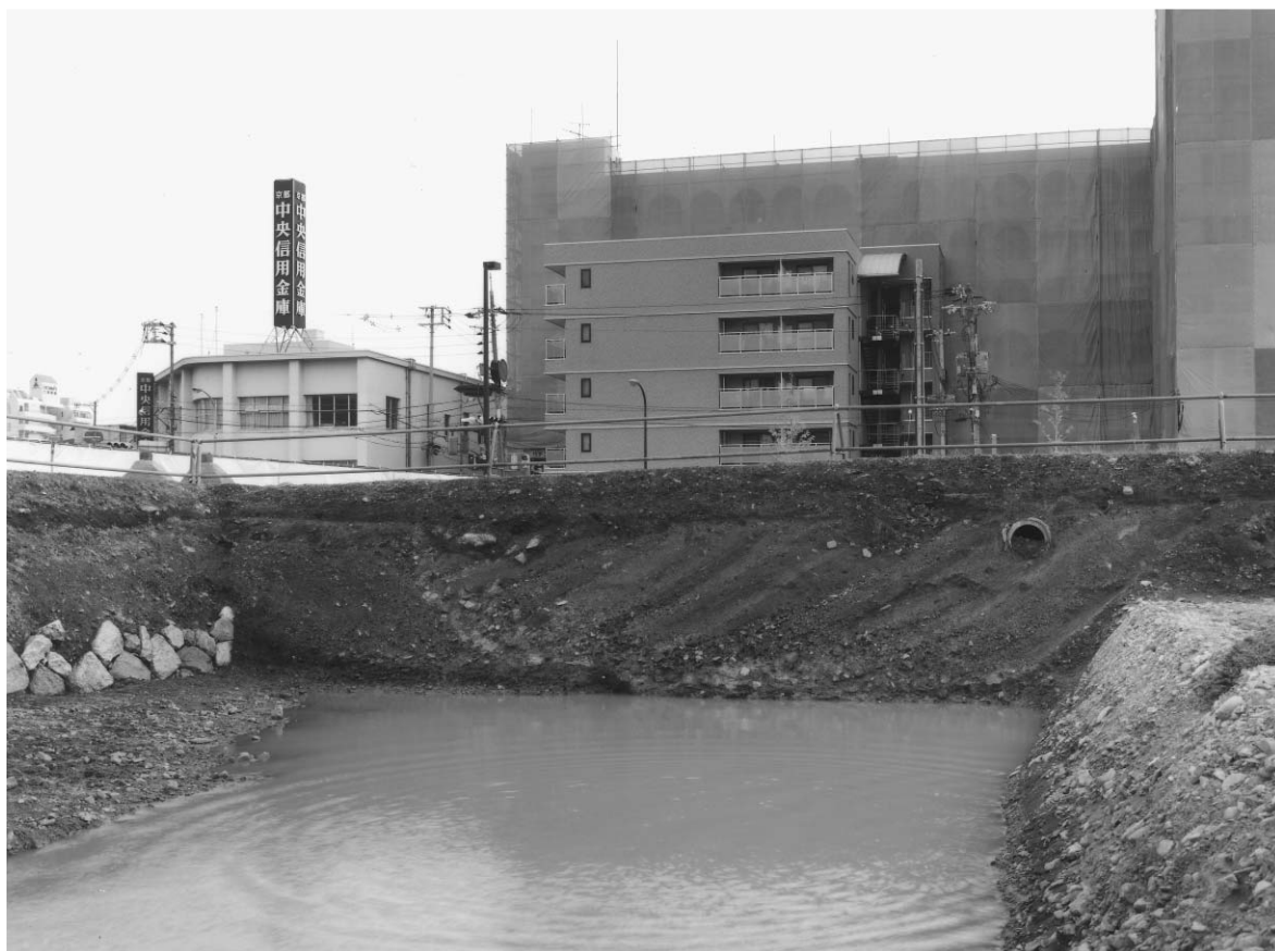
2 西高瀬川舟入りSD70断面（北から）
