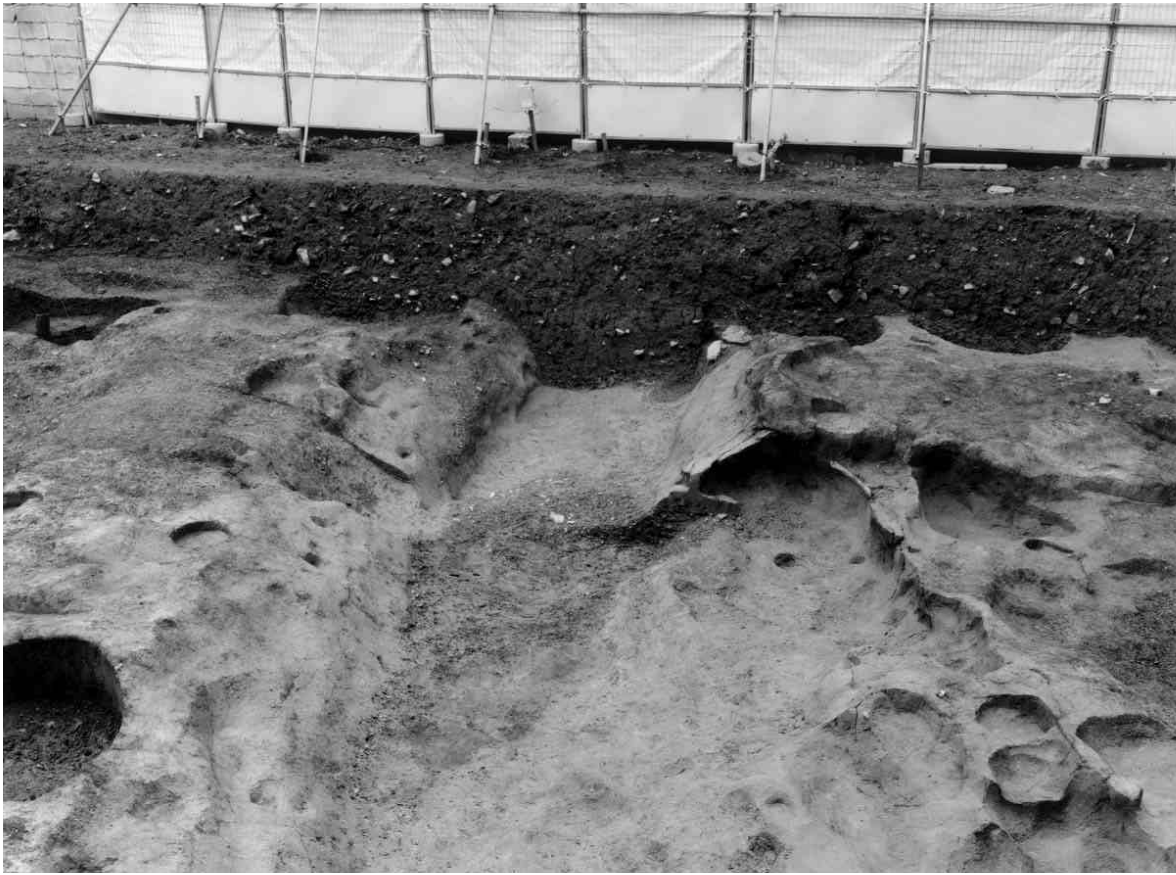
1 溝119完掘状況（東から）
