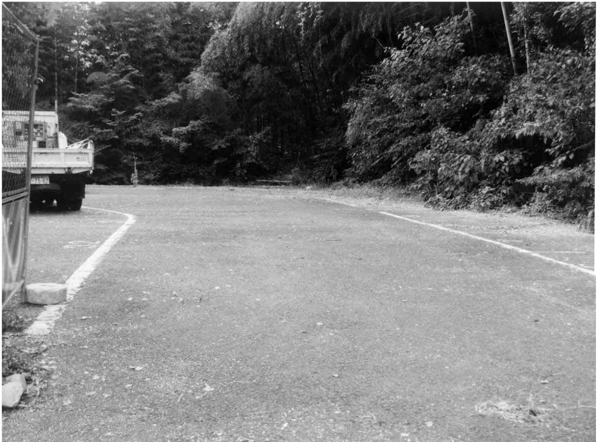
1 調査前全景（北から）
