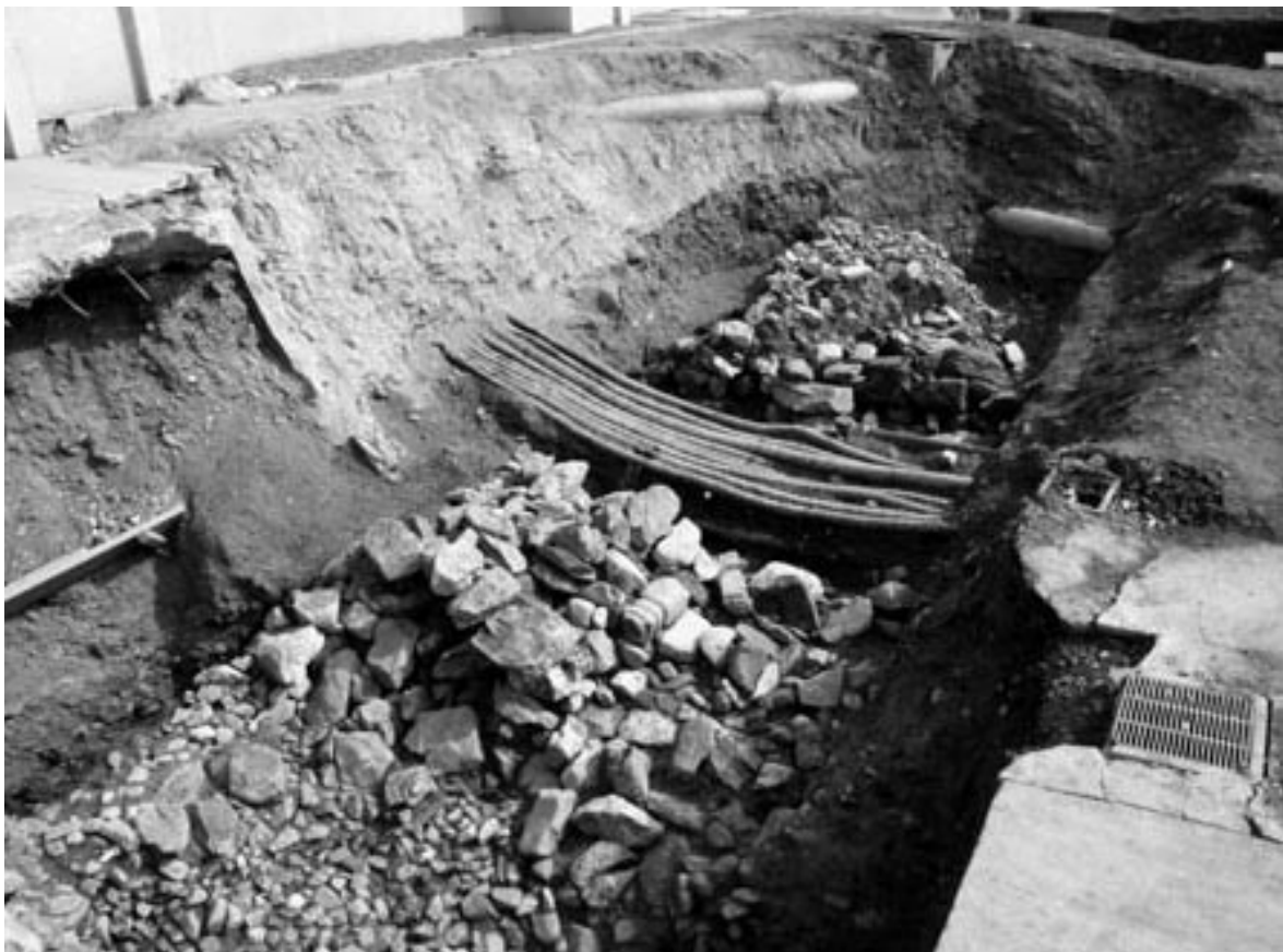
2 10-5区 南面石塁地業（南西から）
