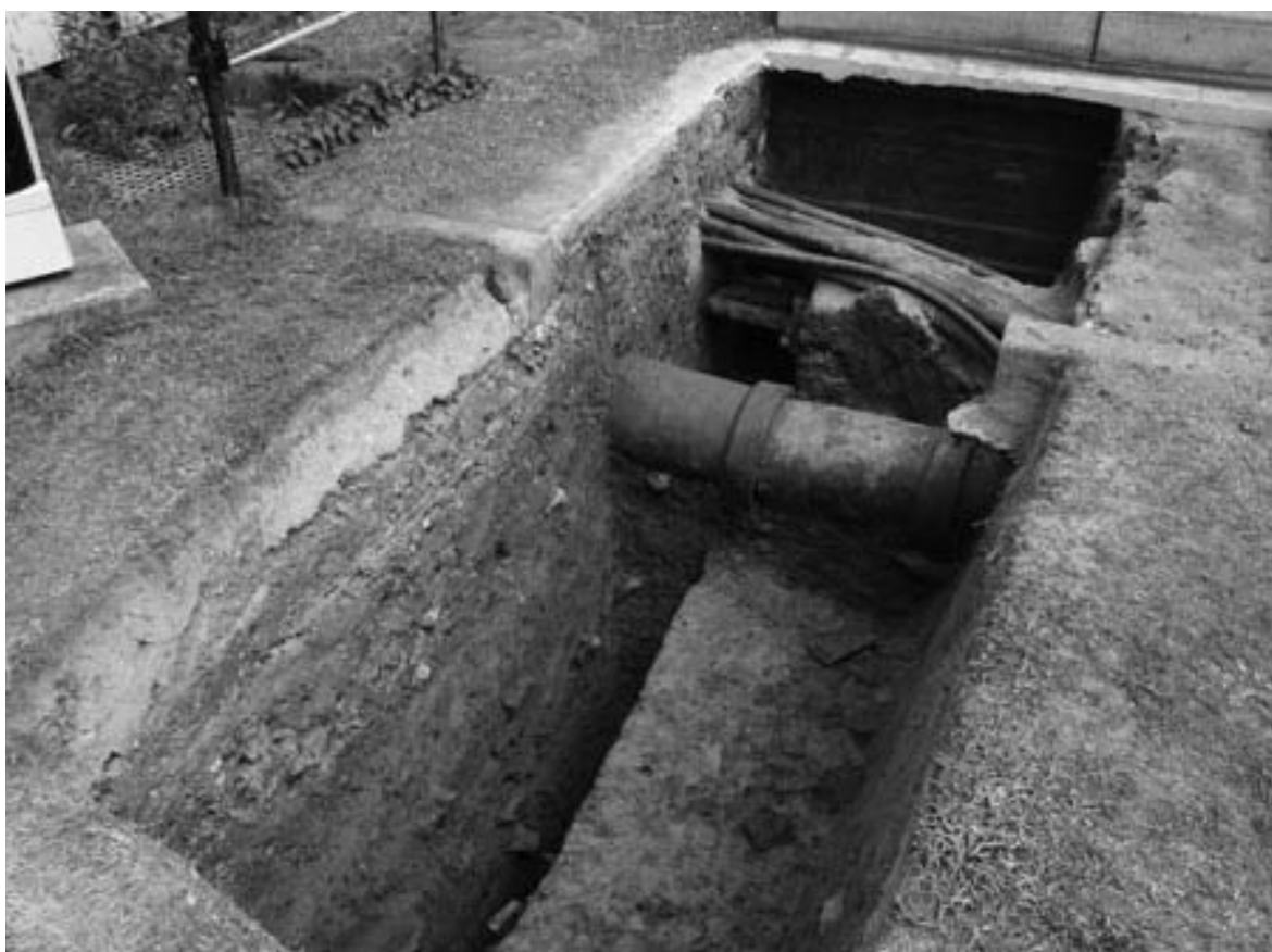
2 1区北端断割後全景（西から）
