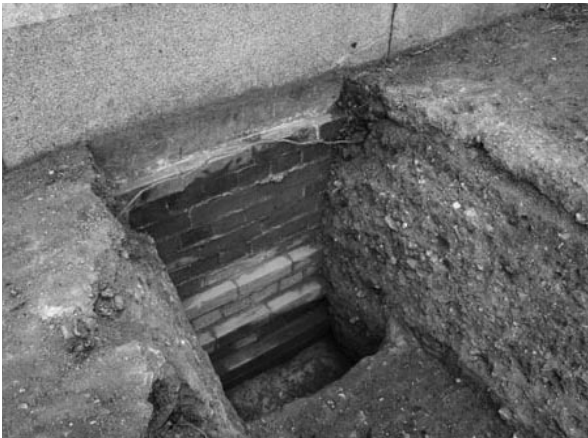
2 7区旧本館基礎検出状況（北西から）
