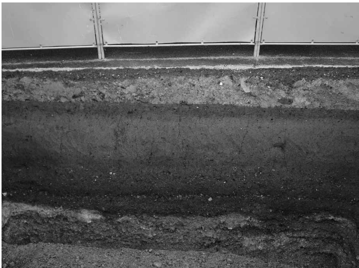
2 7区西壁断割断面（東から）
