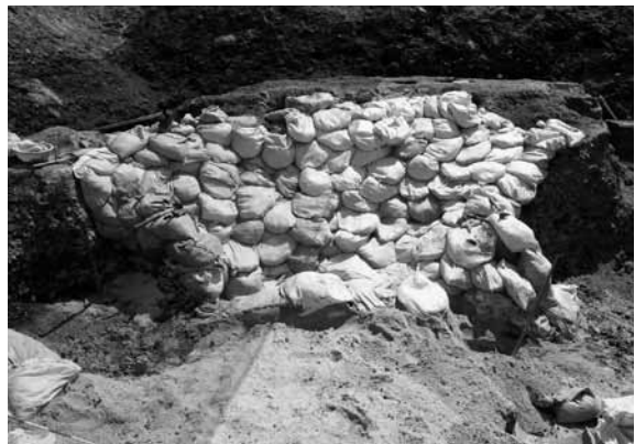
図6 土嚢による滝組の養生状況（北から）
