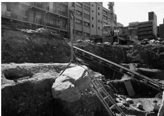
図9 滝組石の取り上げ作業（北東から）
