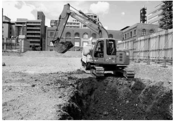
図4 重機掘削状況（東から）
