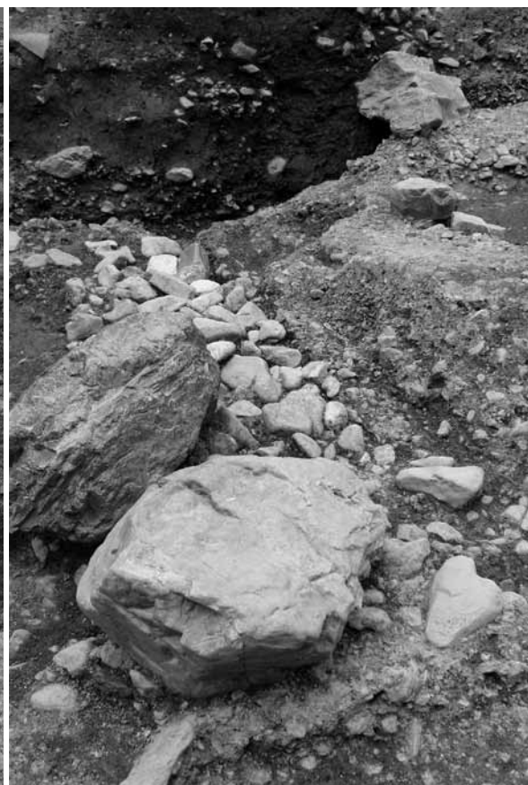
3 池876-2 陸部202基礎構造（南西から）
