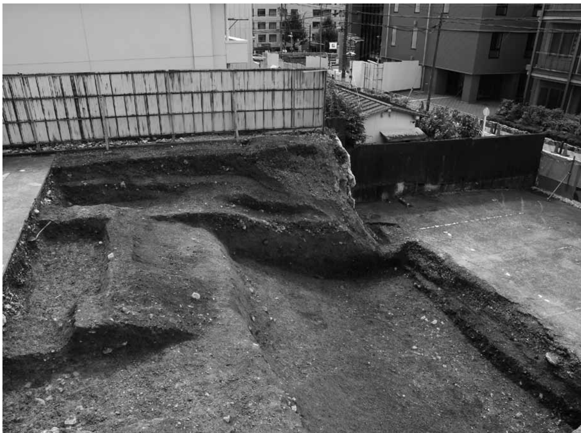
1 南区 第1面全景（北から）
