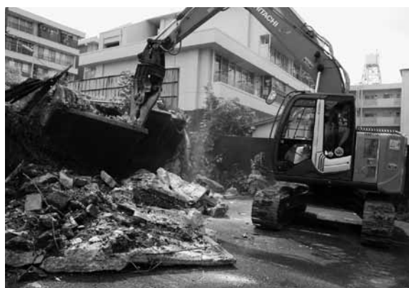
図5 南区構造物解体作業風景 (北から)
