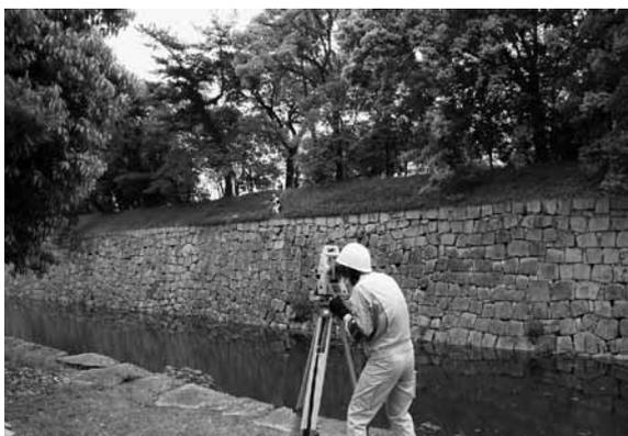
図9 調査その2 石垣オルソ測量風景(北西から)
