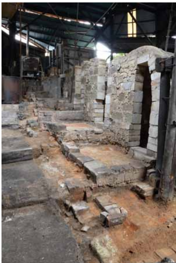
2 旧窯・大正窯北側壁基底部（西から）
