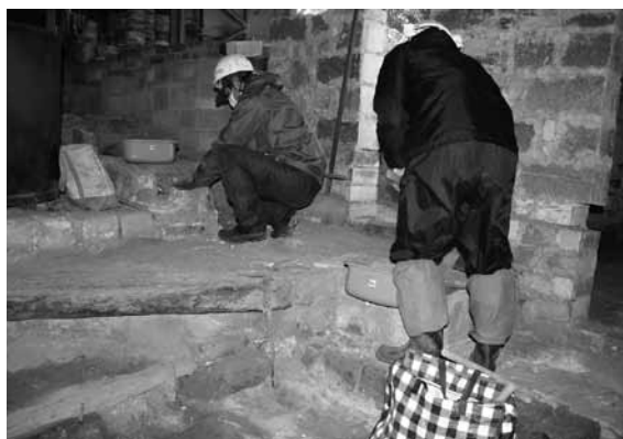
図4 作業風景(北西から)
