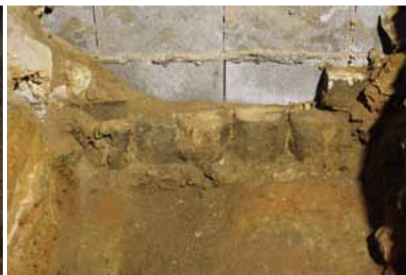
3 大正窯胴木間 内部裾（東から）
