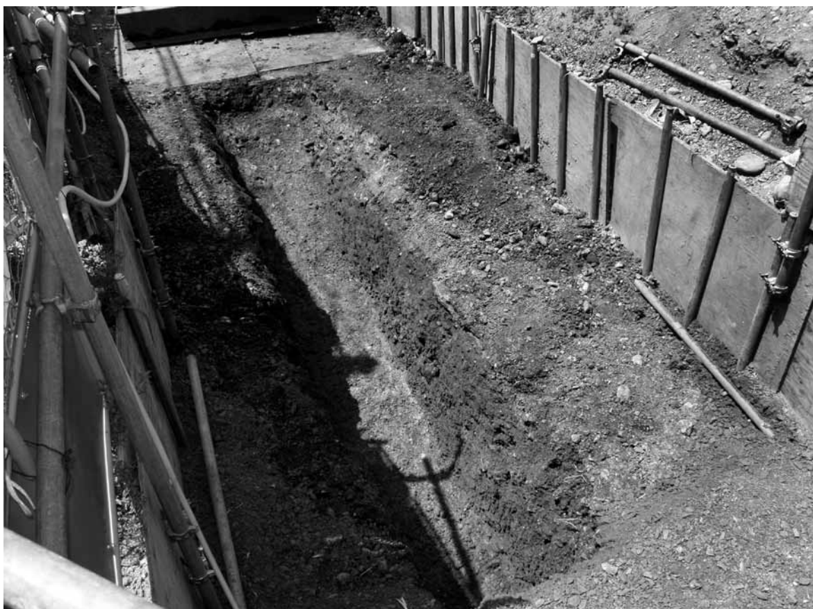
1 東調査区全景（東から）
