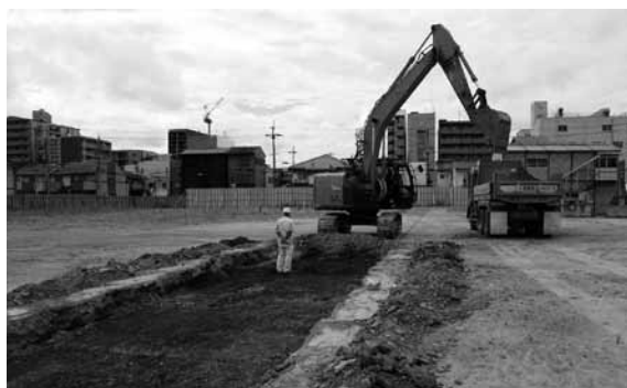
図5 拡張区①重機掘削状況（北西から）
