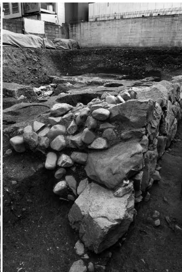
3 石垣50断割断面（北西から）
