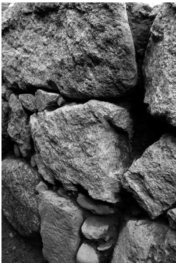
2 石垣50矢穴痕跡（南西から）
