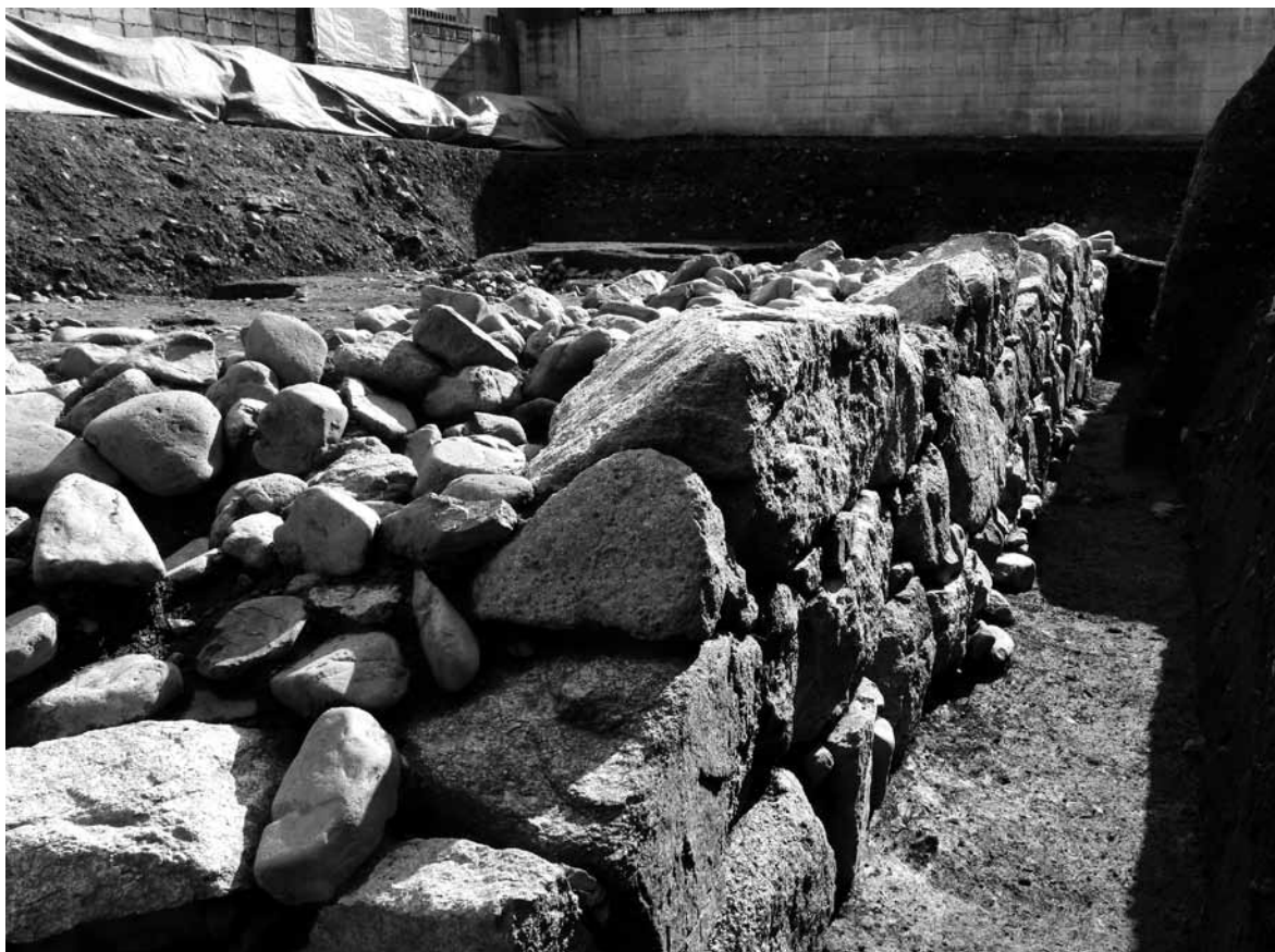
1 石垣50石積み状況（北西から）
