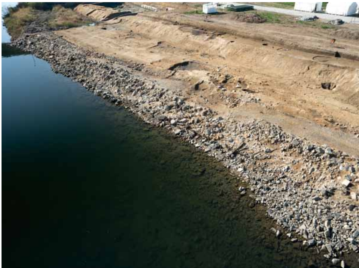
1 護岸3001（北東から）
