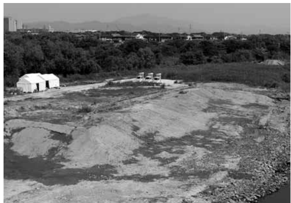
図14 2・3区埋め戻し終了状況（南東から）
