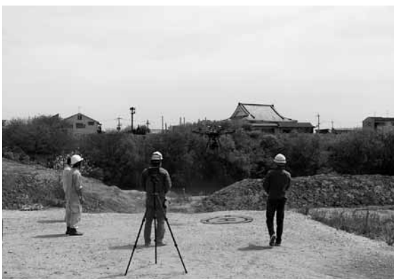
図9 ドローン撮影状況（西から）
