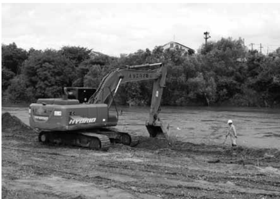
図7 3区重機掘削状況（南西から）
