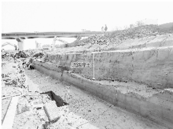
写真11 7地点（流路3400）の堆積状況
