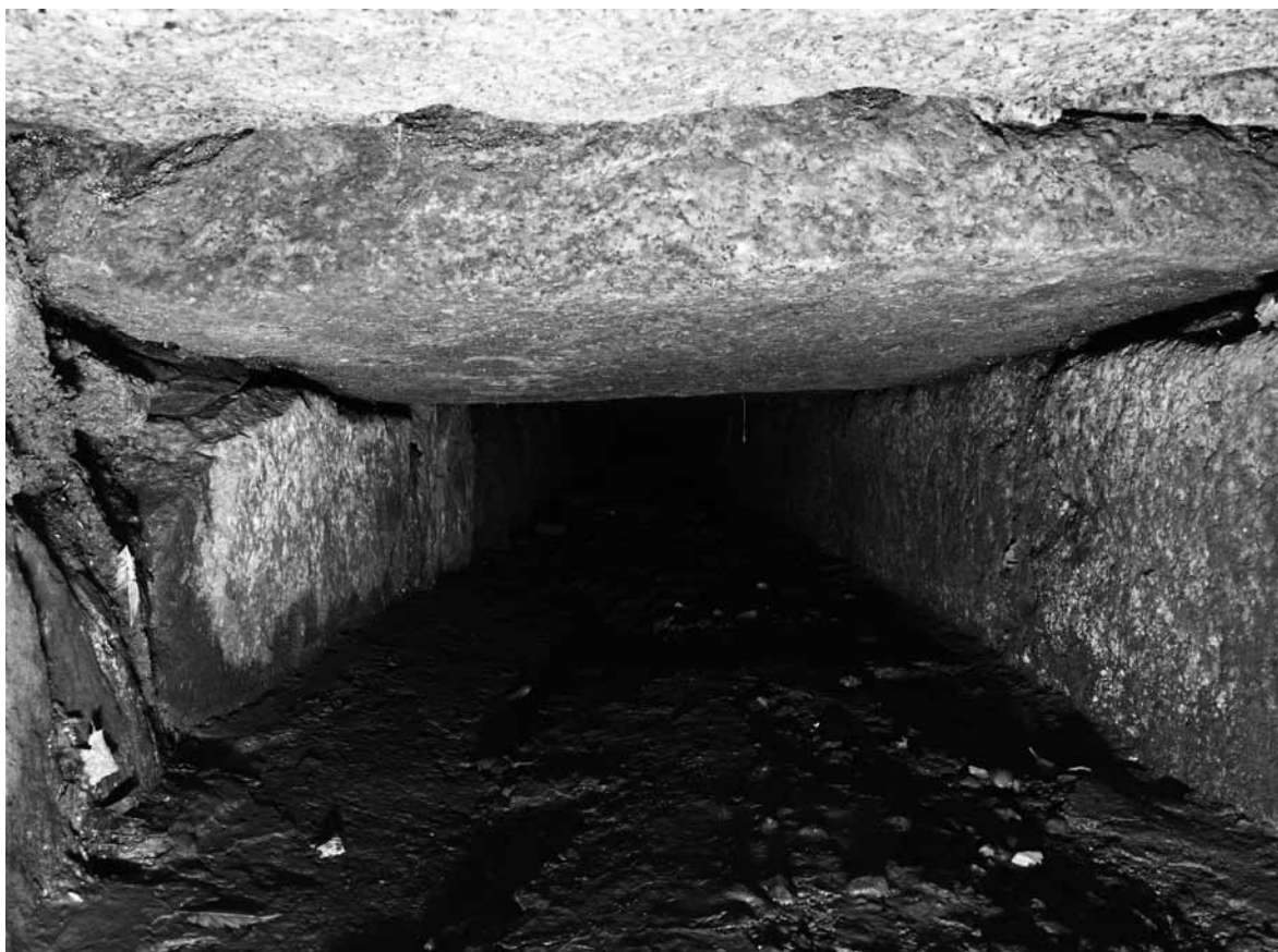
2 2区暗渠12内部状況（調査区南側集水桝より撮影）
