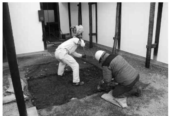
図10 2区埋戻し状況（北東から）
