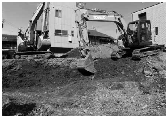
図4 1区重機掘削状況 (南東から)
