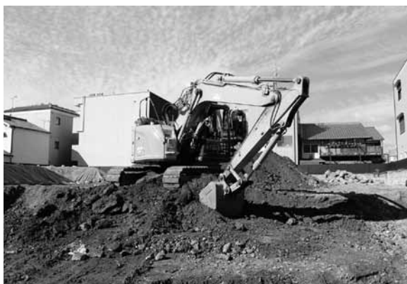
図5 2区重機掘削状況 (東から)
