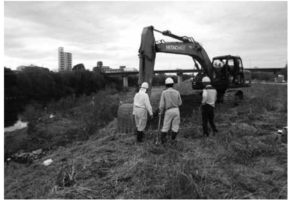
図4 重機掘削状況（北から）
