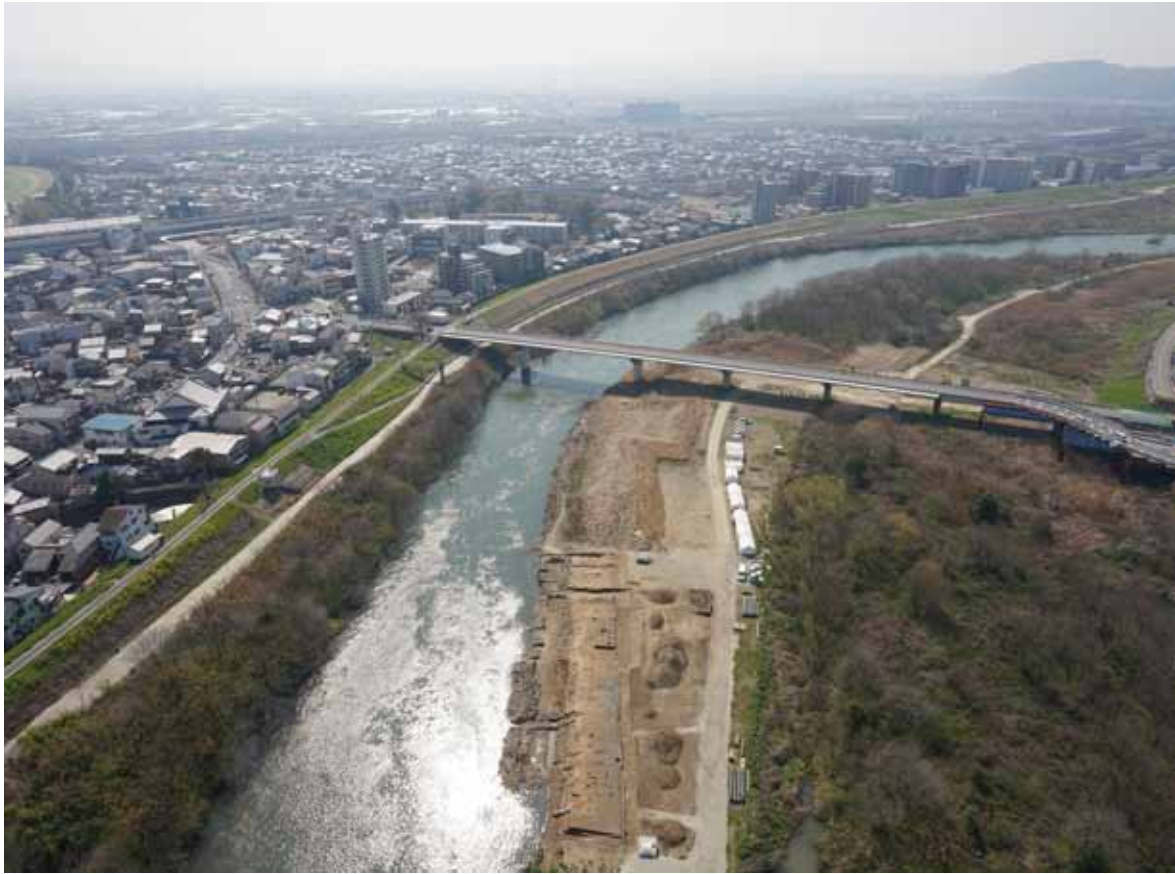
1 調査地遠景（北から）
