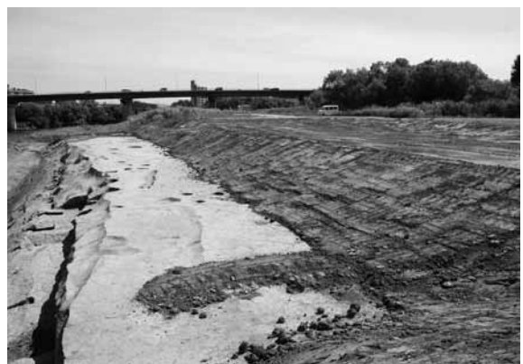
図10 埋め戻し終了状況（北から）
