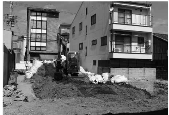
図10 2区埋戻し状況（南東から）
