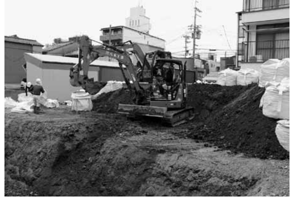
図4 1区重機掘削状況（北東から）
