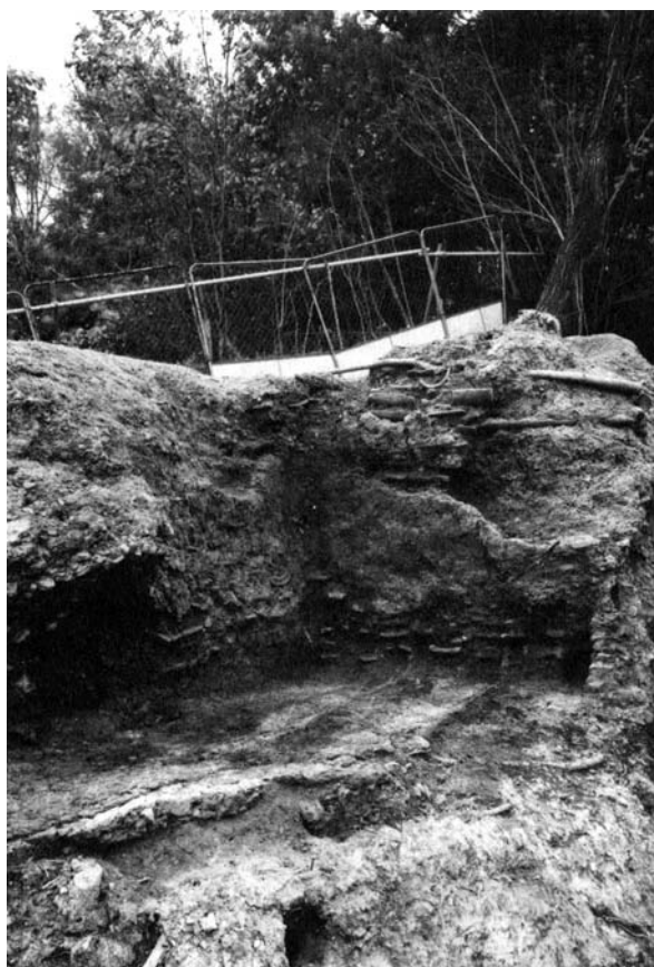
2 当初の側壁および奥壁（北西から）
