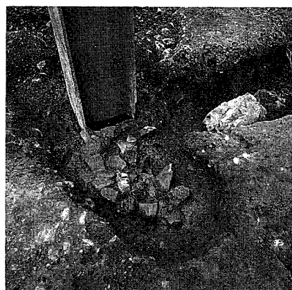
景石除去後の根固め石
