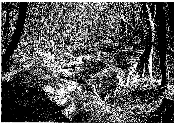
写真8 松尾山H号墳 (天井石が露出)
