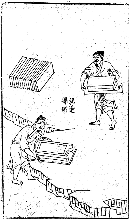
図9 『天工開物』の塼製作図
