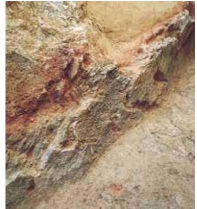
写真3 粘土で補修された箇所
