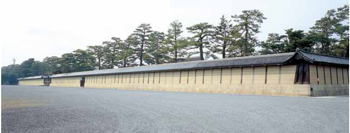
写真1 現在の京都御所 南面築地(南東から)
