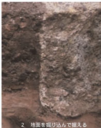
写真2 延石の据え方
