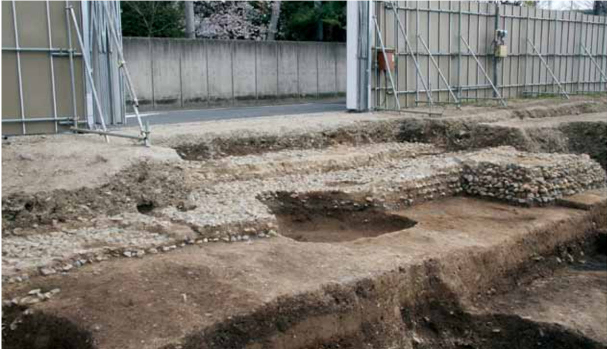
建物の地業（北西から） 周りの整地土を取り外した状態
