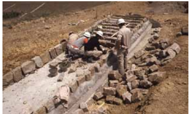
写真7 園路の整備 階段を設置した。
