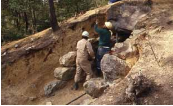
写真2 15号墳 開口部の不安定な石材を積み直した。
