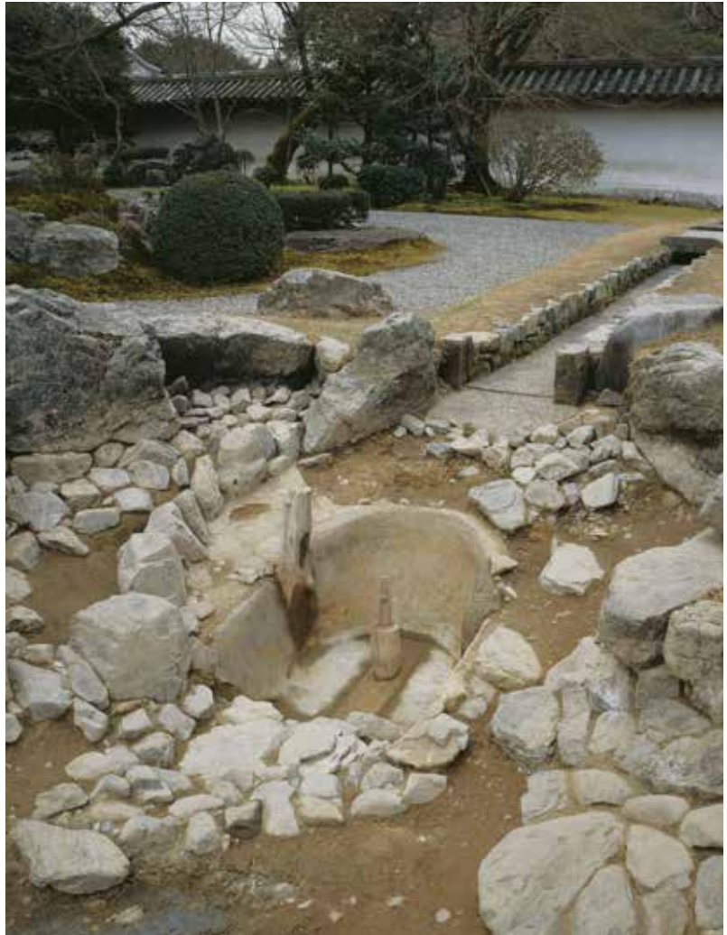
写真1 旧排水施設と改修以前の排水溝（北東から）
