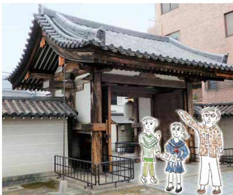
写真3 東寺北総門の南側屋根 軒平瓦に鎌倉時代の瓦も使用されている。(イラスト：上村和直)
