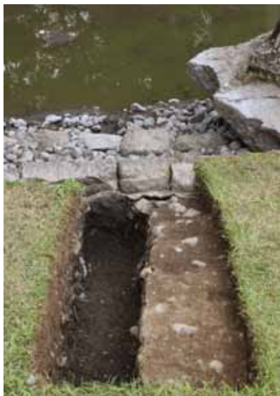
写真2 調査1区（北西から）
