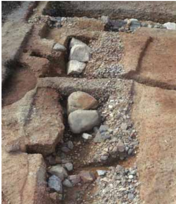
伏見城跡の石垣基礎
