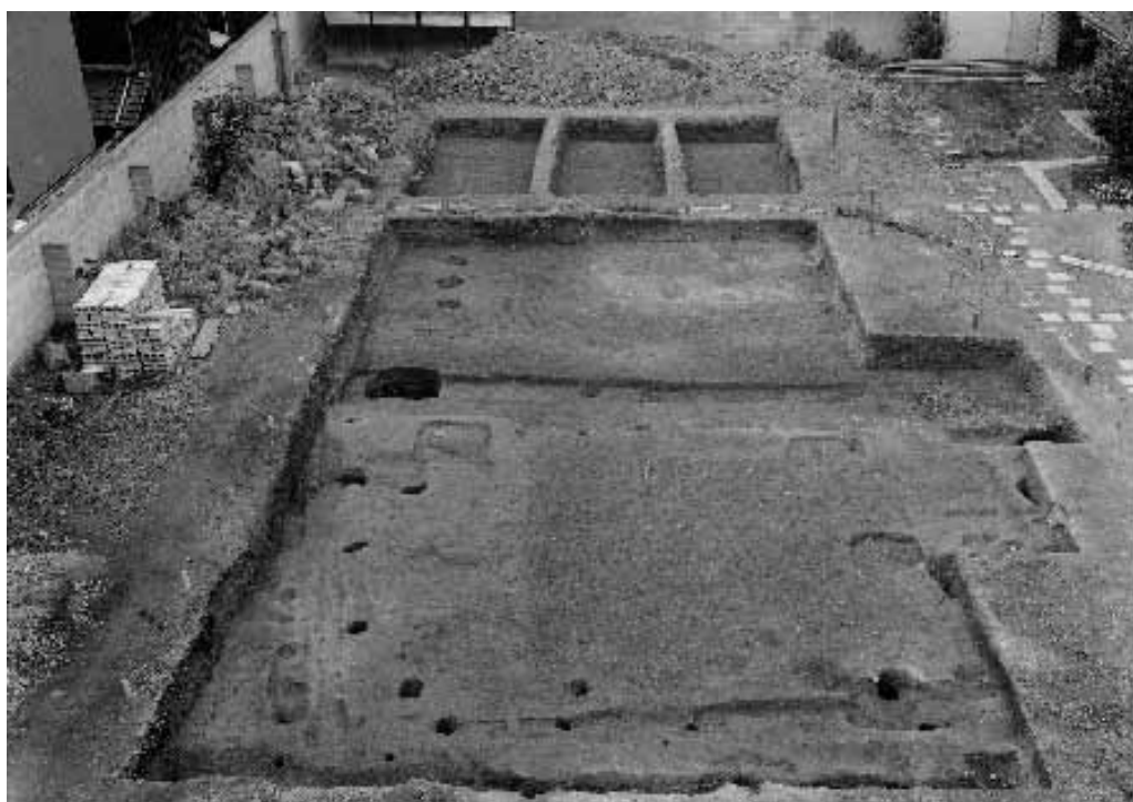
図 120 調査区全景（東から）
