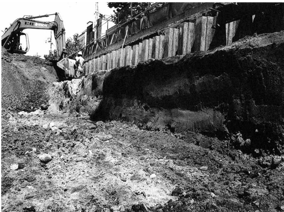
1 No. 16 地点全景（東から）
