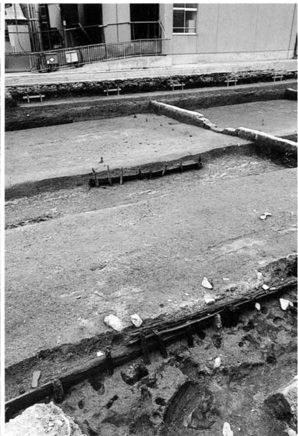
3 護岸施設（北西から）
