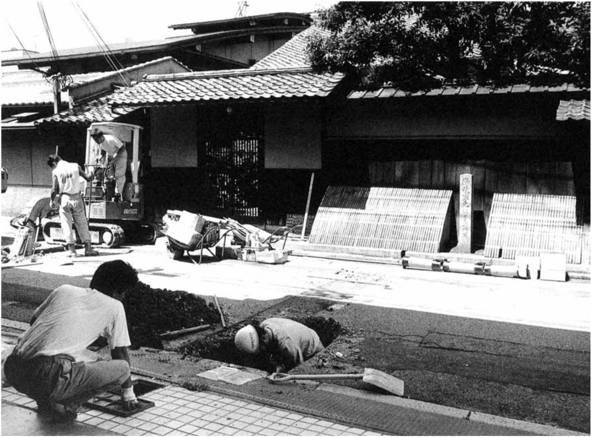
1 No. 24 地点全景（北東から）
