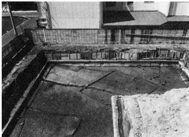
全 景 (古墳時代, 東から)
