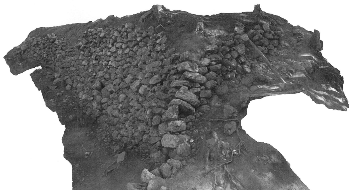
図10 郭5北面及び西面石垣 立面写真
