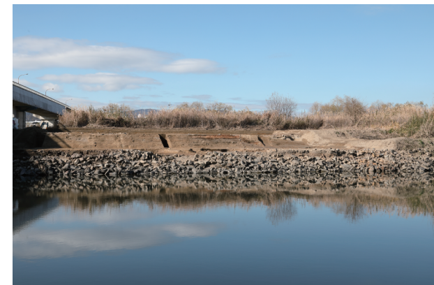
写真11 2区護岸2125検出状況(東から)
